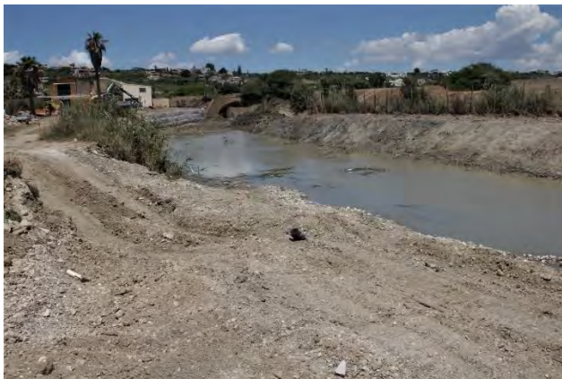
Fig.66 e 67. Torrente Baiata Sciacca (AG) 2.6.2020. La risagomatura e l'eliminazione della vegetazione, è stata avviata dopo i fatti tragici del novembre 2018, quando a causa di un evento piovoso di eccezionale si registrarono esondazioni in parecchi corsi d'acqua e purtroppo anche la morte di una decina di persone nella Sicilia occidentale. Anche dalle foto si può evincere come vi siano anche altre possibilità d'intervento, ad esempio allargando e rinaturalizzando il corso d'acqua per ridurre il rischio idrogeologico e migliorare la qualità ambientale.
