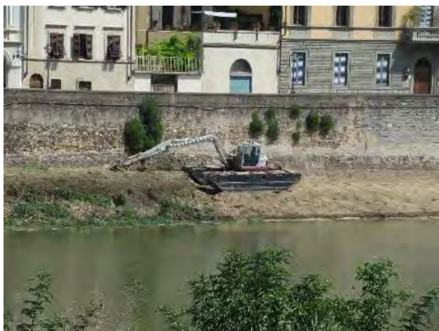
Figg. 59 e 60. Fiume Arno (FI) 22.10.2019. Taglio e rimozione sedimenti fluviali e vegetazione a cura del Consorzio di Bonifica 3 Medio Valdarno. Utilizzo di escavatore anfibio a valle di Ponte Vecchio fino alla Pescaia di Santa Rosa
