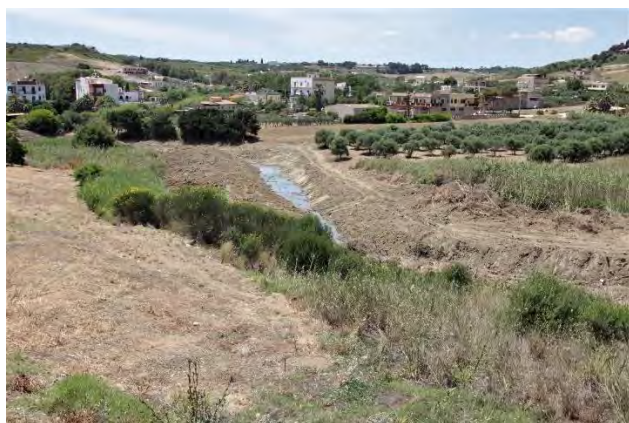
Fig.66 e 67. Torrente Baiata Sciacca (AG) 2.6.2020. La risagomatura e l'eliminazione della vegetazione, è stata avviata dopo i fatti tragici del novembre 2018, quando a causa di un evento piovoso di eccezionale si registrarono esondazioni in parecchi corsi d'acqua e purtroppo anche la morte di una decina di persone nella Sicilia occidentale. Anche dalle foto si può evincere come vi siano anche altre possibilità d'intervento, ad esempio allargando e rinaturalizzando il corso d'acqua per ridurre il rischio idrogeologico e migliorare la qualità ambientale.
