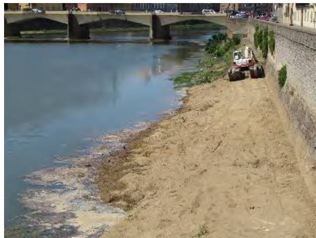
Figg. 59 e 60. Fiume Arno (FI) 22.10.2019. Taglio e rimozione sedimenti fluviali e vegetazione a cura del Consorzio di Bonifica 3 Medio Valdarno. Utilizzo di escavatore anfibio a valle di Ponte Vecchio fino alla Pescaia di Santa Rosa
