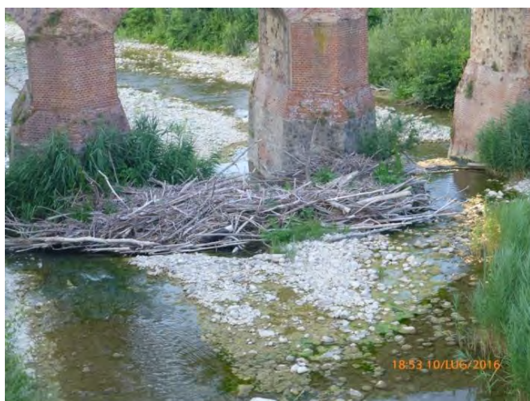
Fig. 18. 10.7. 2016 piloni del Ponte di Pianoro Vecchio
