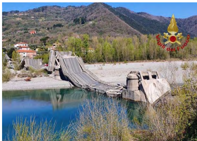
Figg.75 e 76. Cedimenti recenti: sulla sinistra ponte sul fiume Paglia (2.3.2020) e sulla destra sul Magra in località Albiano lungo la Sp70 (8.4.2020) Solo mancanza di manutenzione o anche l'abbassamento dell'alveo ha contribuito a rendere instabile l'intera struttura?
