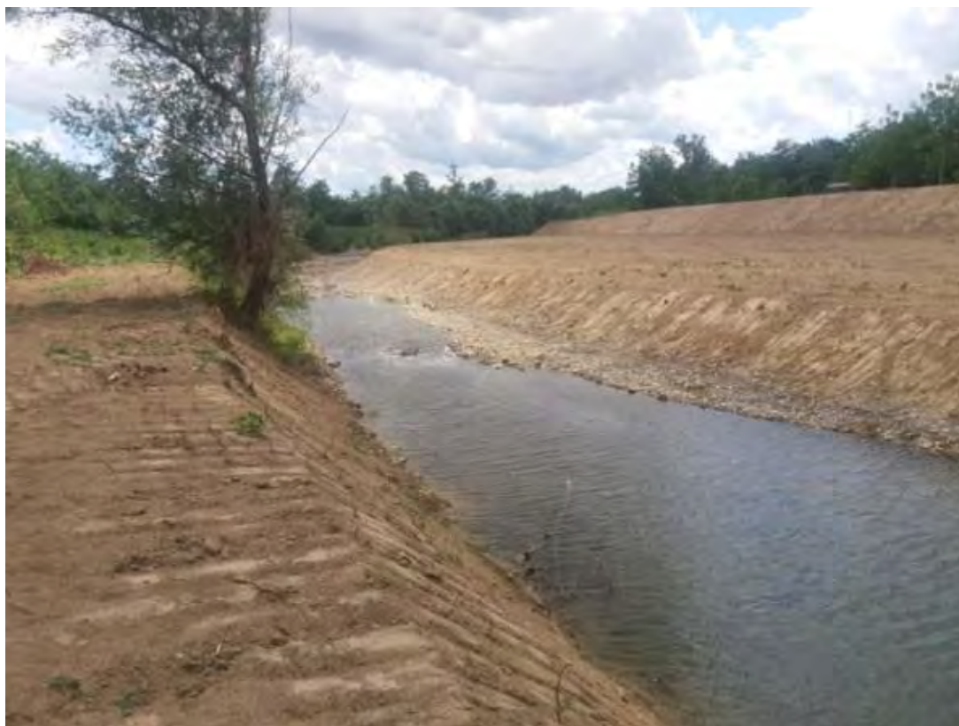
Fig.65. Torrente Arbia (2018) Lavori di taglio raso della vegetazione riparia
