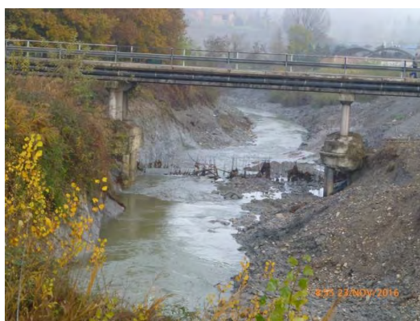
Fig.25. 23.11.2016; il ponte di V. Serrabella viene chiuso; iniziano i lavori di consolidamento
