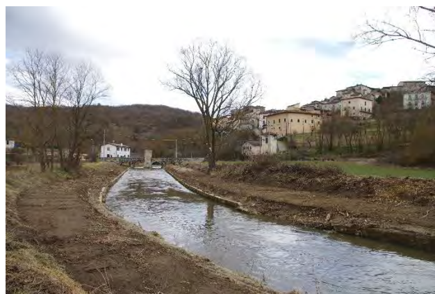
Figg. 8 e 9. 2017 L'Aterno presso il ponte romano a Campana. E' evidente come il ponte, in parte coperto dal terrapieno degli argini, ha poco spazio per far defluire anche una piena ordinaria e quindi ne tende ad ostacolare il passaggio
