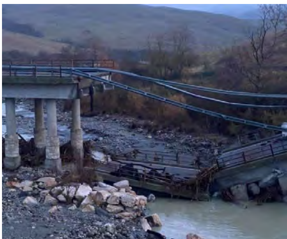
Figg.75 e 76. Cedimenti recenti: sulla sinistra ponte sul fiume Paglia (2.3.2020) e sulla destra sul Magra in località Albiano lungo la Sp70 (8.4.2020) Solo mancanza di manutenzione o anche l'abbassamento dell'alveo ha contribuito a rendere instabile l'intera struttura?
