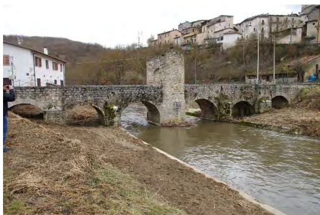
Figg. 8 e 9. 2017 L'Aterno presso il ponte romano a Campana. E' evidente come il ponte, in parte coperto dal terrapieno degli argini, ha poco spazio per far defluire anche una piena ordinaria e quindi ne tende ad ostacolare il passaggio
