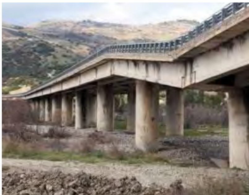
Fig.73. Ponte sul Basento
