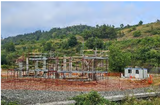
Figura 1. Un edificio in costruzione
