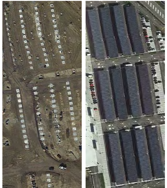
Figura 129. Esempio di pensiline fotovoltaiche a copertura di parcheggi auto (circa 1,3 ettari), comune di Torrazza Piemonte (Torino)
