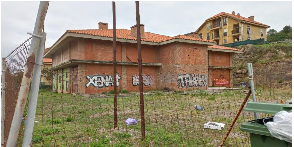
Figura 10. Un edificio abbandonato
