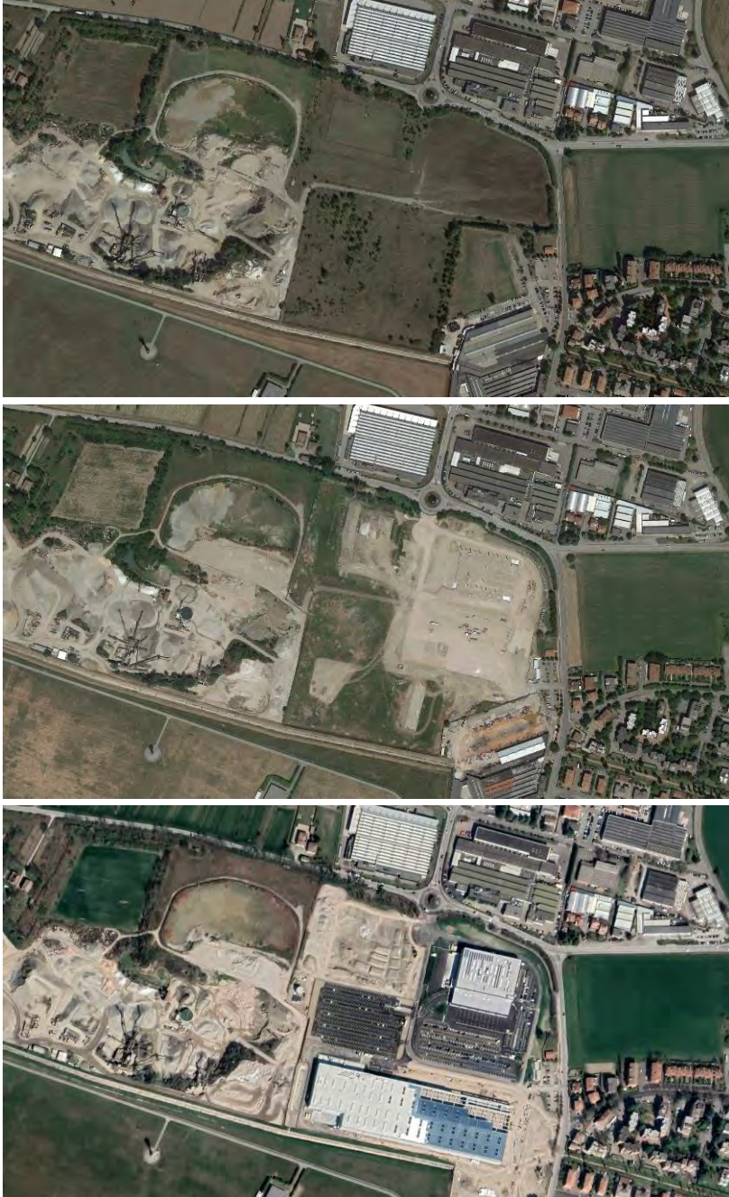
Figura 94. Costruzione di due fabbricati (classe 111, per un totale di ettari 3,21), di un piazzale/parcheggio (classe 116, di circa 5 ettari) e cantiere limitrofo (classe 122, di ettari 5,4) nel Comune di Caldera di Reno (Bologna). Immagini relative agli anni 2020, 2021 e 2022
