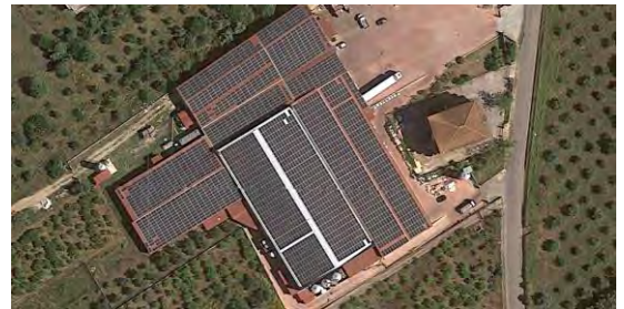
Figura 131. Esempi di tetti fotovoltaici (circa 1,2 ettari), comune di Altavilla Milicia (Palermo)
