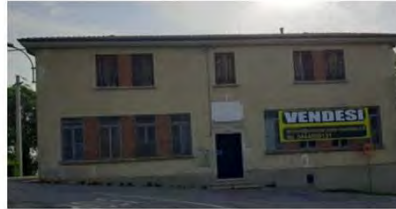
Demolizione ex scuole elementari di Ignago-Isola Vicentina
