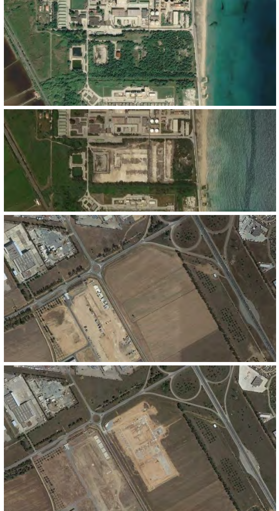
Figura 173. Esempi di consumo di suolo rilevato fra gli anni 2019 e 2022 nei SIN di Priolo (Siracusa, ettari 5,65) e Sulcis-Iglesiente-Guspinese (Sardegna, circa 6 ettari). Nelle immagini si può osservare l'avvio di nuovi cantieri
