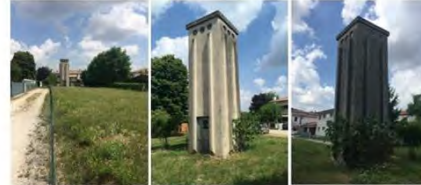
Demolizione della ex cabina ENEL - Povegliano
