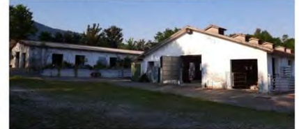
Demolizione fabbricato ad uso stalla - Chiappano
