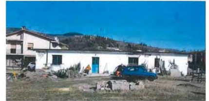
Demolizione di un fabbricato in disuso - Tregnago
