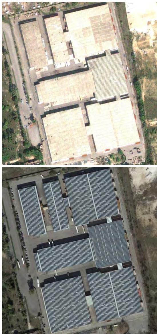
Figura 132. Esempi di tetti fotovoltaici (circa 5 ettari), comune di Tivoli (Roma). Impianto da oltre 4,2 MW
